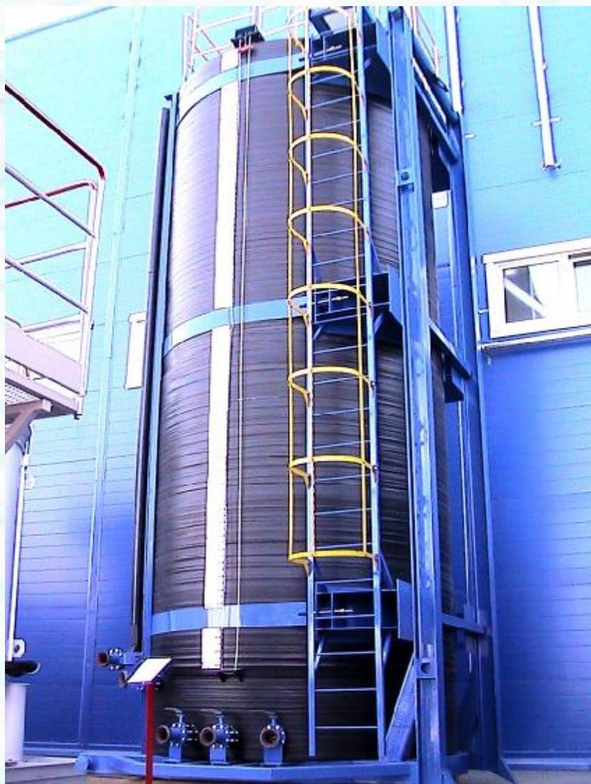
Рис. 12 Ёмкость ЕТ50.КВП с профилем стенки SPR вертикальная  $V=50\text{м}^3$  для производства работ по гидроразрыву пласта (ГРП)
